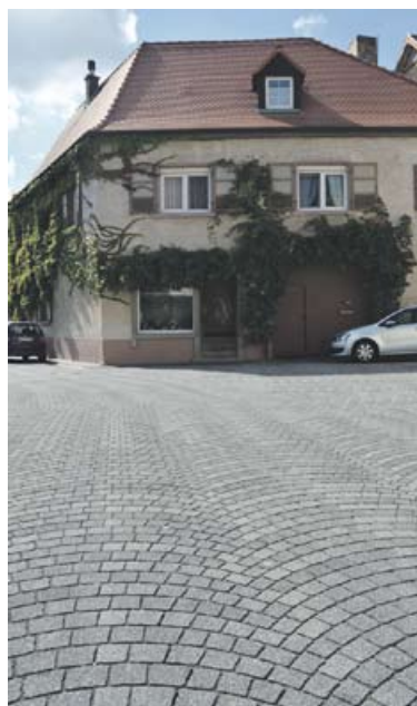
Perfekte Flächenbefestigung für eine Weinbaugemeinde: Das basaltfarbige Betonsteinpflaster passt optisch und bietet dank seiner Verbundtechnologie guten Halt für die anfallenden Verkehrsbelastungen.
