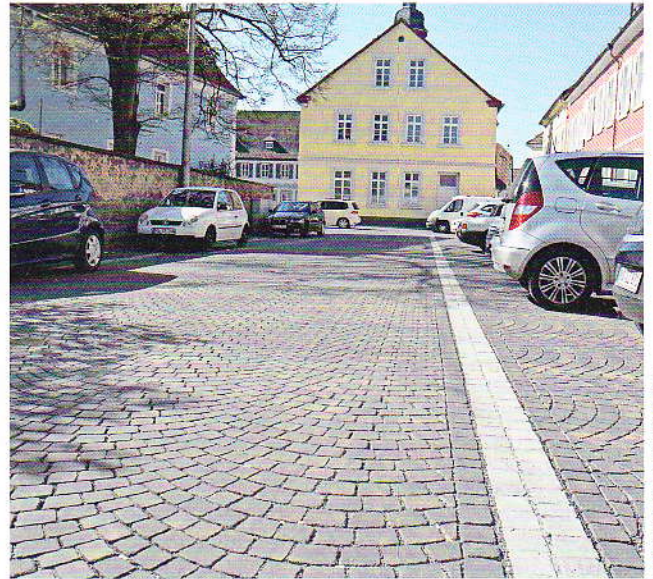
Im weiteren Verlauf rund um das Rathaus wurde die Kehler Straße samt Pkw-Stellflächen mit dem Segmentbogenpflaster neu befestigt.
