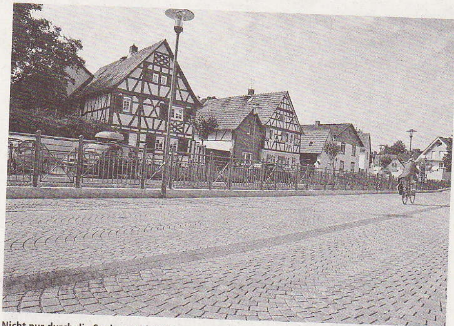
Nicht nur durch die Sanierung der Ufermauern erhält das gesamte Areal ein neues Gesicht, auch das Segmentbogenpflaster im Farbton weinlaub leistet hierzu einen wichtigen Beitrag.
