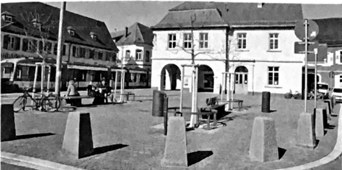
Nachher: Durch die Sanierung erhält der Platz ein neues Gesicht, auch das Segmentbogenpflaster leistet hierzu einen wichtigen Beitrag. FOTOS: BETONWERK PFENNING
