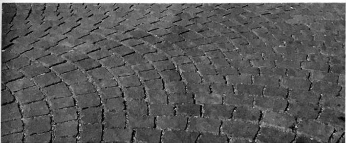
Auch die Kehler Straße neben dem Rathausplatz konnte mit dem Segmentbogenpflaster befestigt werden. Dank der Verbundsteintechnologie sind Verschiebungen in der Fläche aufgrund von Verkehrsbelastung nicht zu befürchten.
