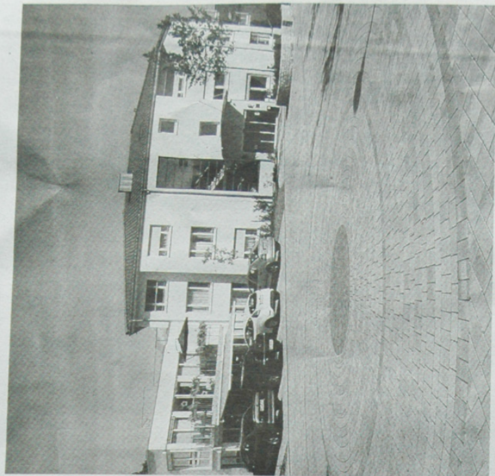
Barrierefreier Platz: Durch die Aufhebung der Grenzen zwischen Fahrbahn, Gehwegen und Flächen für den ruhenden Verkehr wurde eine sehr großzügige Flächengestaltung in einer Ebene realisiert.
