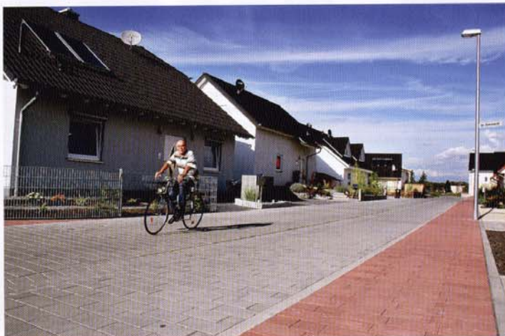
Siedlung Sonneneck: Trotz intensiver Nutzung während der Bauphase sind keinerlei Verschiebungen im Straßenbelag erkennbar. Fotos: Einstein-Fugentechnik
