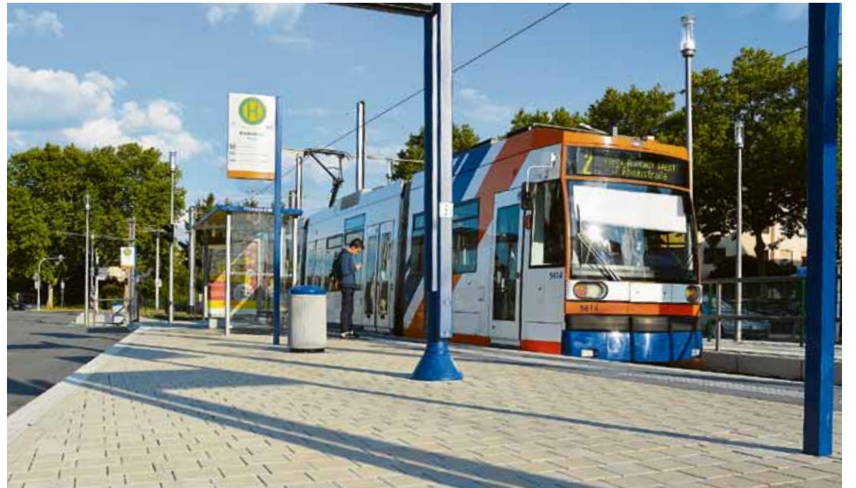
Die Rhein-Neckar-Verkehr GmbH setzt seit Jahren beim ÖPNV-Ausbau in Mannheim auf das verschiebesichere Pflastersystem CombiStabil.
