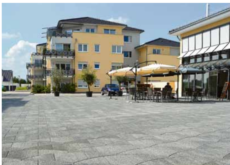
Das Betonsteinpflaster in der Oberfläche passt optisch und bietet dank seiner Verbundtechnologie guten Halt für die anfallenden Verkehrsbelastungen.
