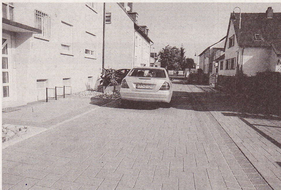
Bereits im Jahre 2011 wurde mit dem Pflastersystem CombiStabil die Bleichstraße im Ortsteil Beindersheim saniert. Bis heute liegt das Pflaster trotz der üblichen Verkehrsbelastung wie eine Eins. Foto: Einstein-Fugentechnik
